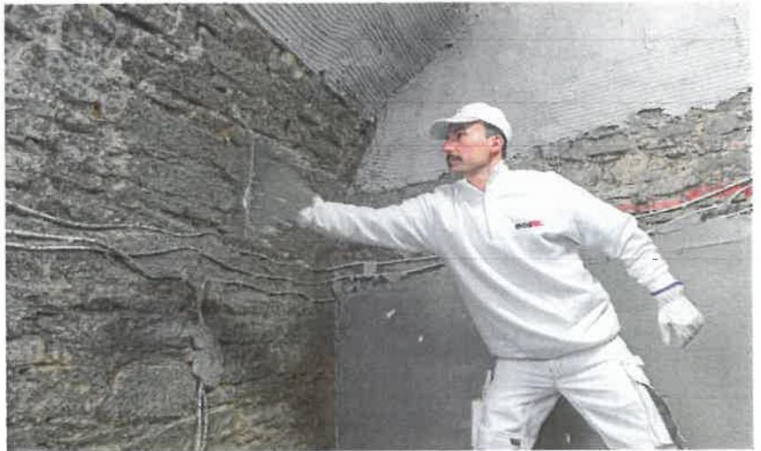
Rechts Mitte: Nach der gründlichen Reinigung der Wände mit einem Sandstrahler wird hier die erste Schicht mit Dichtputz aufgebracht.
